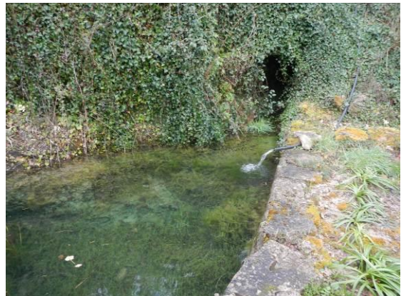
Bassin avec arrivée d'eau de source
