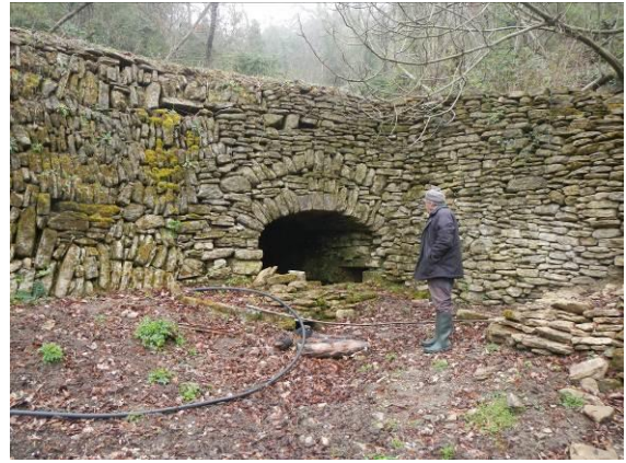
Ouvrage en pierre sèche – Mine d'eau
