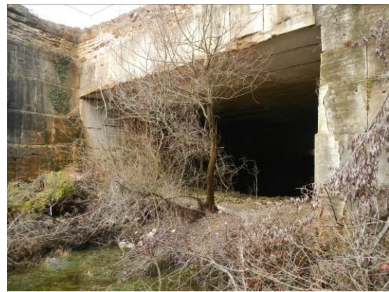
Ouvrage de soutènement
