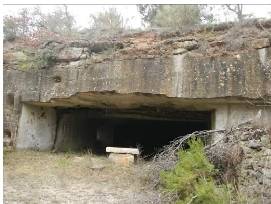
Entrée dans l'ouvrage
