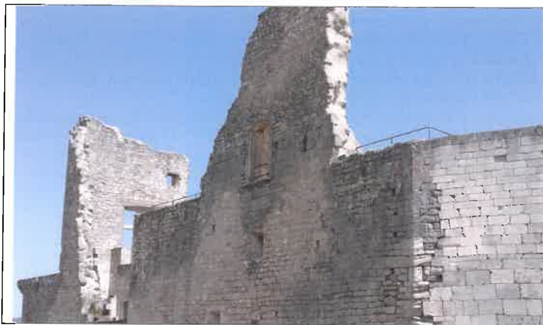
- Lacoste : façade du château
