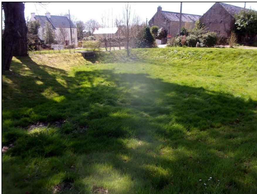
Photo 7 : Vue du bassin d'orage du lotissement Pro-Braz
