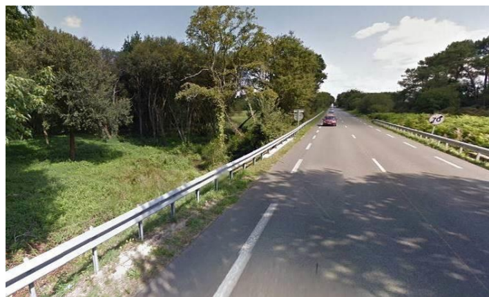
Corridor écologique traversé par la RD 768 (vue en direction du nord)
