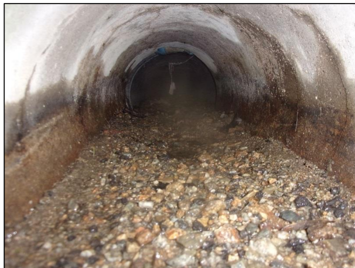
Photo 3 : Vue d'un réseau à curer – Rue de la Grotte (Ø300)
