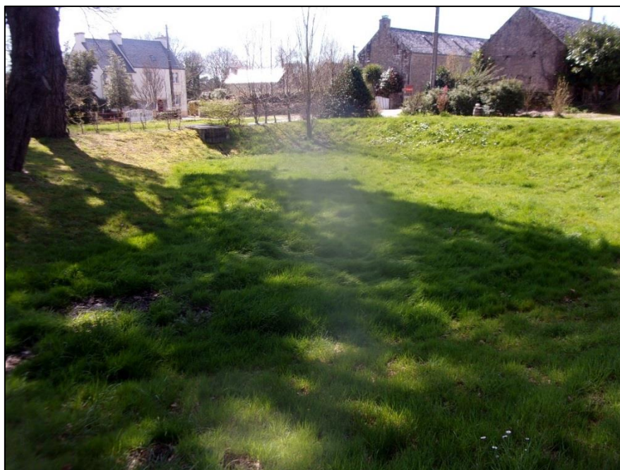
Photo 7 : Vue du bassin d'orage du lotissement Pro-Braz
