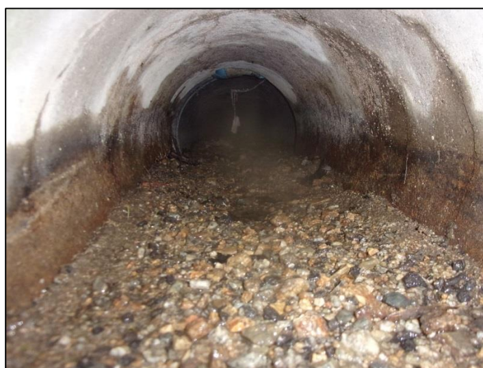
Photo 3 : Vue d'un réseau à curer – Rue de la Grotte (Ø300)
