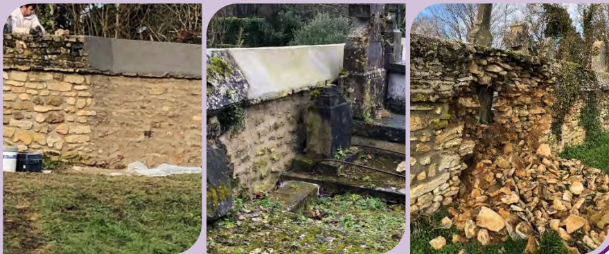
Réparation d'un mur du cimetière par la société AZEL.
