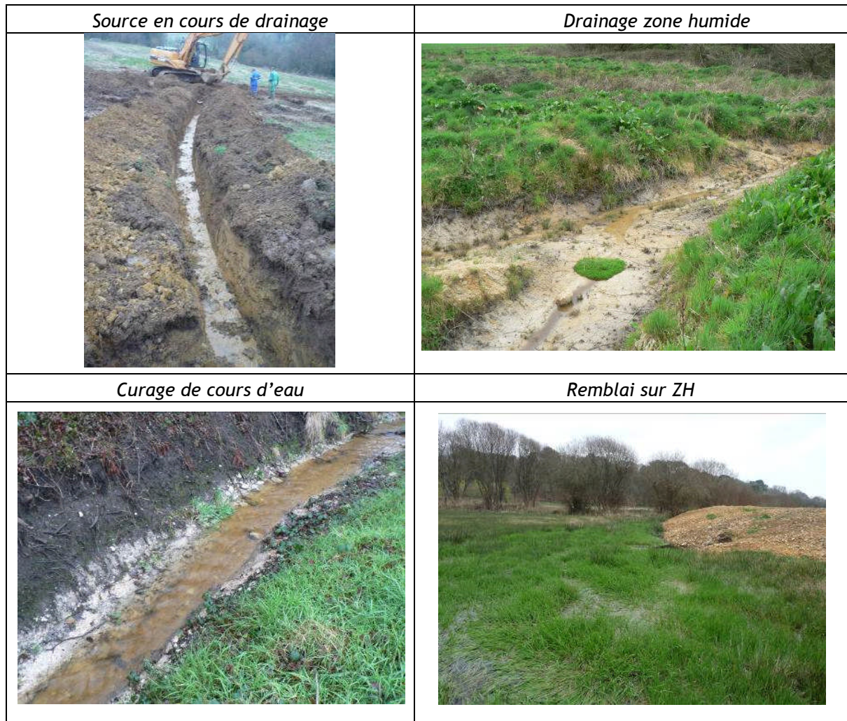
Exemples de dégradations proscrites et/ou soumises à réglementation en matière de cours d'eau et de zones humides
