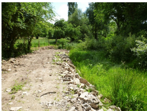
Remblai sur zone humide (Id : 977) - Locmiquel
