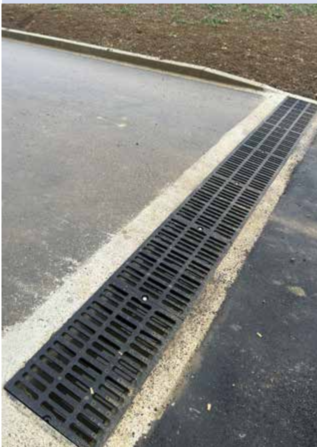
Création d'un aco drain en haut de la rue de la Forêt.
