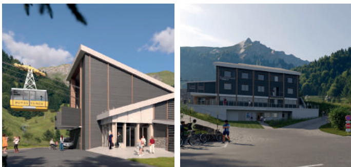
Rénovation de la gare de départ (intérieur et extérieur) : Création au RDC d'une billetterie et d'une boutique
