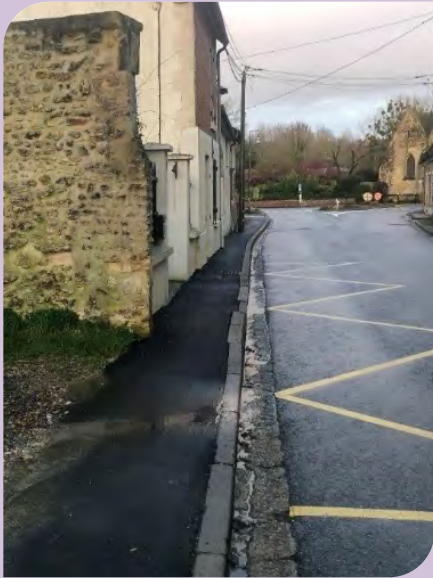
Rénovation des trottoirs par la société PEREZ.
