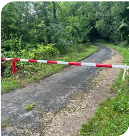
Fabrication d'une barrière.
