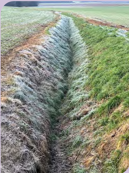
Curage des fossés.
