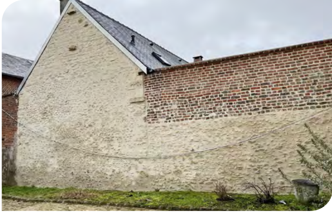
Rejointement du mur dans la cours de la MAM et reprise des piliers de l'entrée par la société AZEL.
