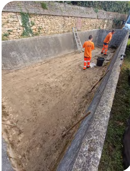
Nettoyage du bassin.
