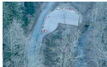
Réaménagement du parking de Fontestorbes
