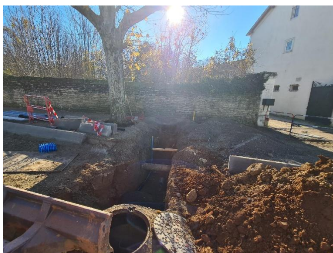
Création amorce réseau d'eau entrée terrain ccvd
