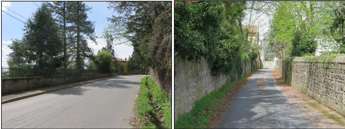
Exemples de murets sur le site
