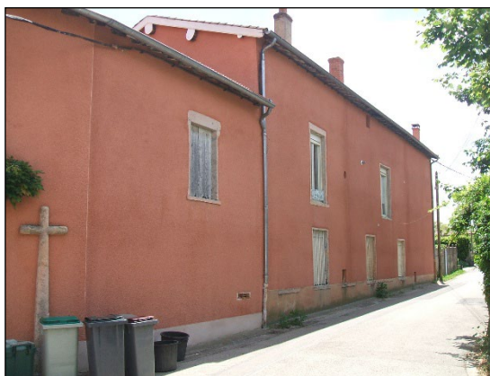
Vue sur la façade est
