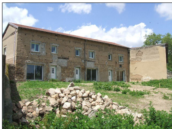
Vue sur la façade est
