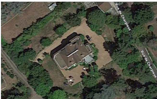
Vue aérienne sur le site
