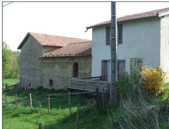
Vue sur la façade arrière
