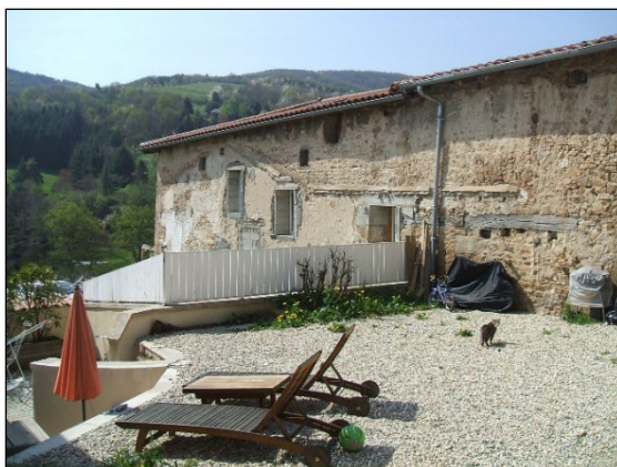
Vue sur le hangar
