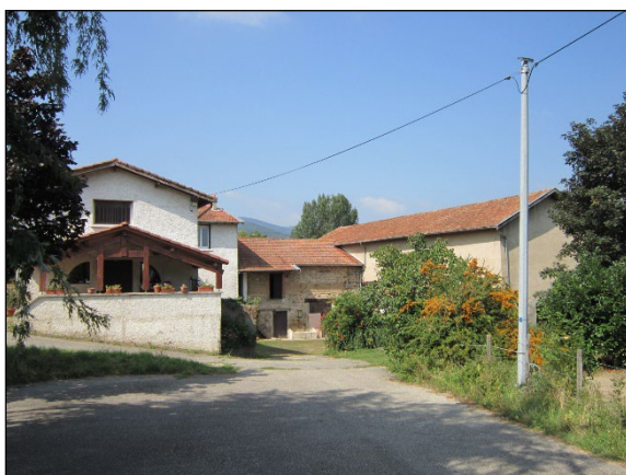
Vue sur la façade principale
