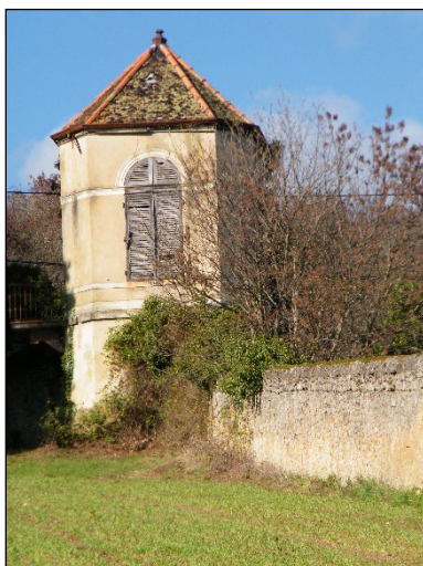
Tourelle aux Adrets
