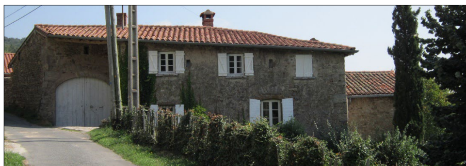
Vue sur la façade ouest du bâtiment
