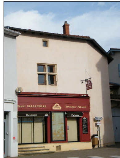
Fenêtre à meneaux dans le bourg
