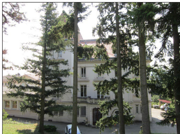
Vue sur la façade nord
