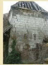
La tourelle de l'ancien château démolie en 2009
