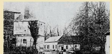
La tourelle de l'ancien château démolie en 1900
