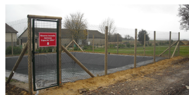
Réserve incendie du haut du village
