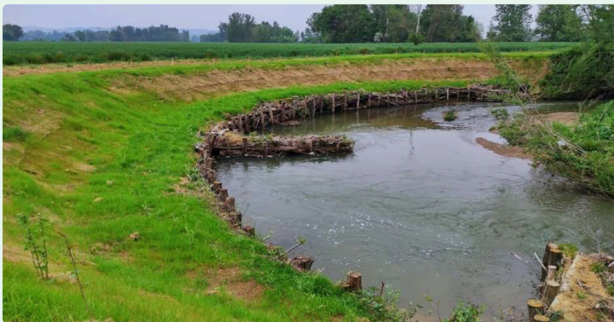
Renaturation avec création d'habitats aquatiques à Cadeillan - SYGESAVE©
