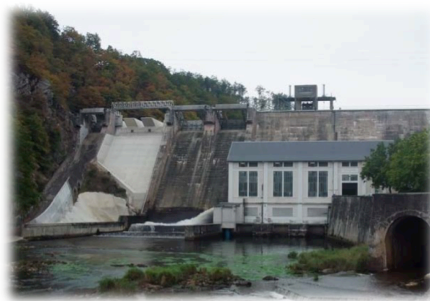
Photo 54 : Barrage hydroélectrique de Saint-Marc
