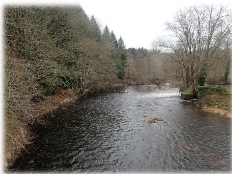
Photo 1 : La Gartempe à Châteauponsac
