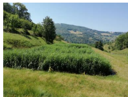
Figure 8 : Station d'épuration à filtres plantés de roseaux à Yzeron (Source : riviere-yzeron.fr)
