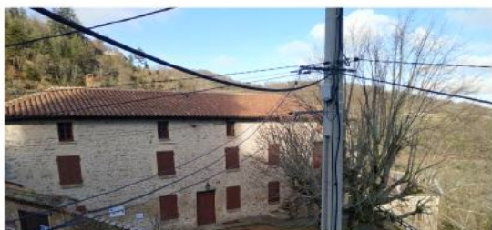
Maison de l'aire
