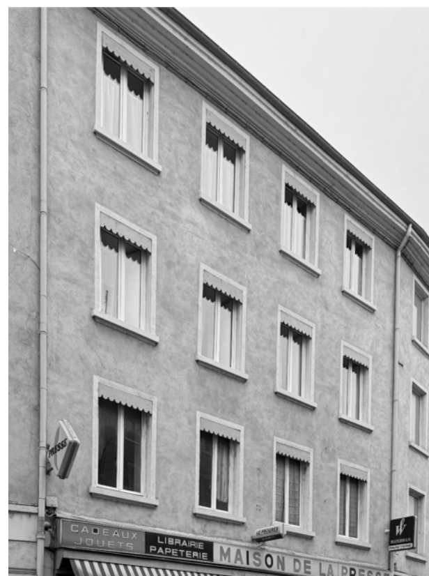
Ensemble de fenêtres neuves occultées par des volets roulants dont le caisson est masqué par un lambrequin décoratif.
