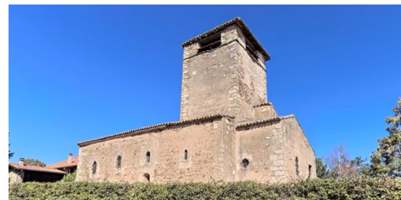
Les matériaux de construction d'Yzeron : principalement de la pierre enduite à la chaux naturelle avec sable de rivière. (Chapelle de Châteaueux)
