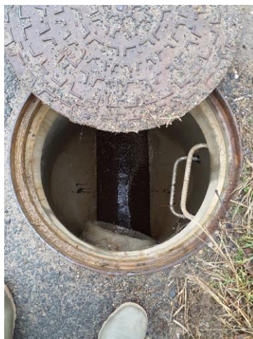
Arrivée des eaux pluviales dans le réseau UN à côté de la grille du chemin de Brally
