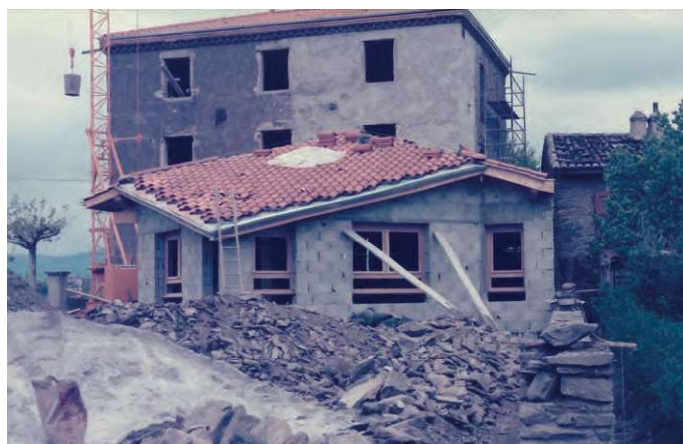
Ecole Planil 1984-1984 Travaux rénovation et extension
