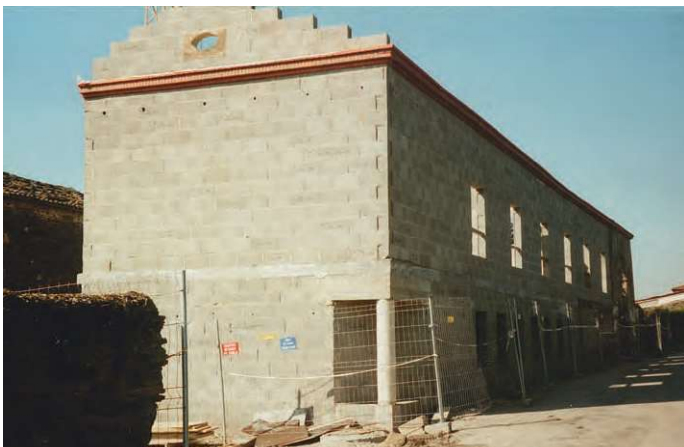
Mairie Rue Pierre Mussieux - ferme Coin 2001-2003 - rénovation coté rue P Mussieux
