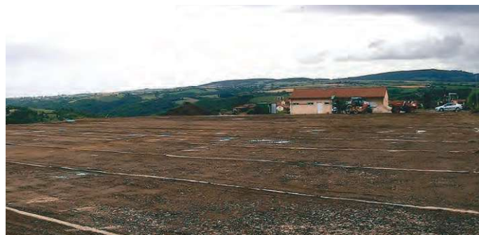
Construction du stade en synthétique 2007
