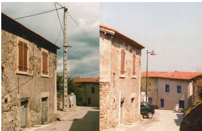
Rue Pierre Mussieux - enfouissement des lignes électriques
