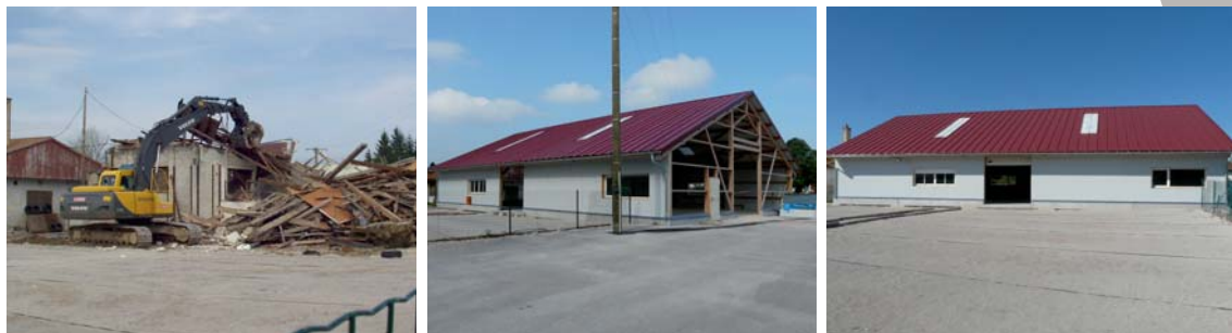
Démolition de l'ancien quai de gare pour faire place au boulodrome.
