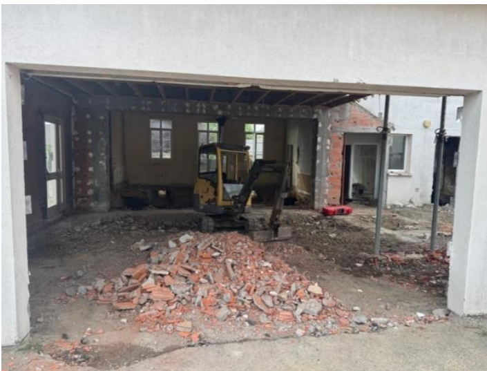
Baie vitrée de la salle
