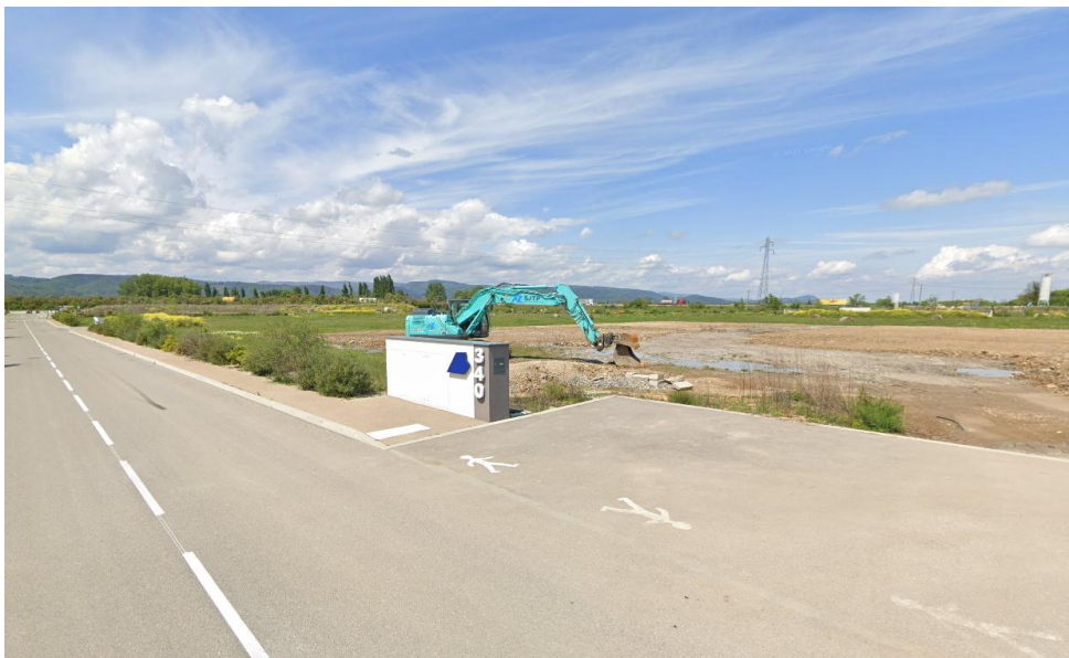
Localisation de l'OAP ZAC Confluence / Vue depuis le chemin des Saules (vers le nord)
