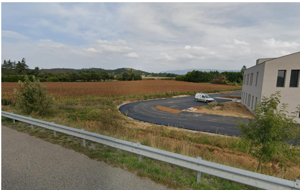
Localisation de l'OAP Grand Pré / Vue depuis la RD125
