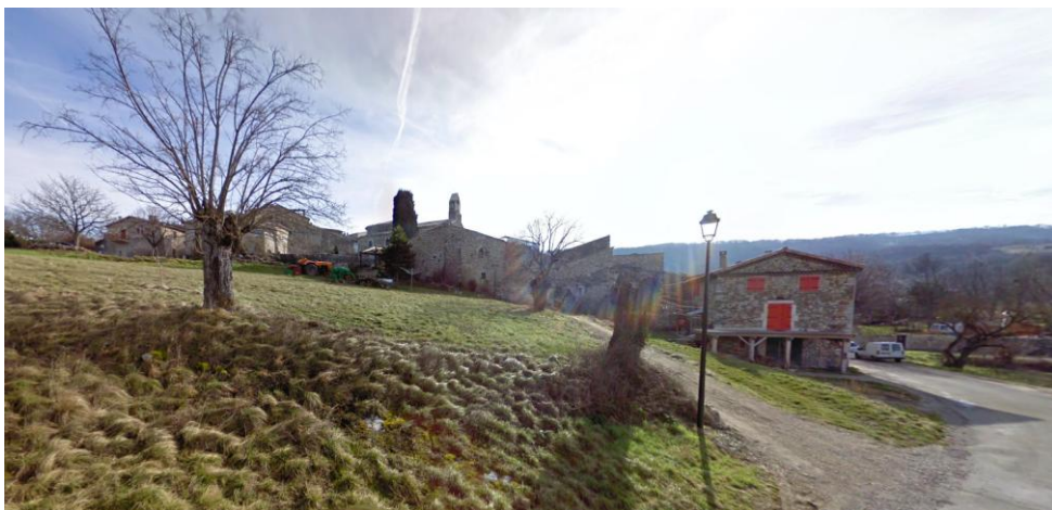
Localisation de l'OAP Rue de l'Eglise / Vue depuis le contrebas du site, vers le bourg historique
