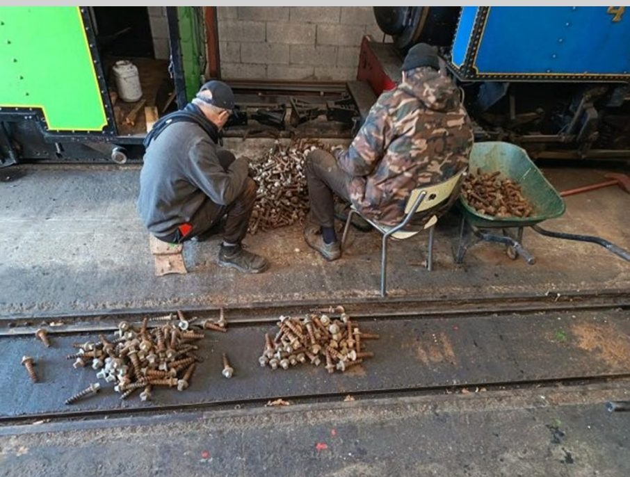
Un travail pas fatigant et passionnant, le tri des tirefonds sortis de la voie à Salles: bons à conserver et pas bons à valoriser chez le ferrailleur
