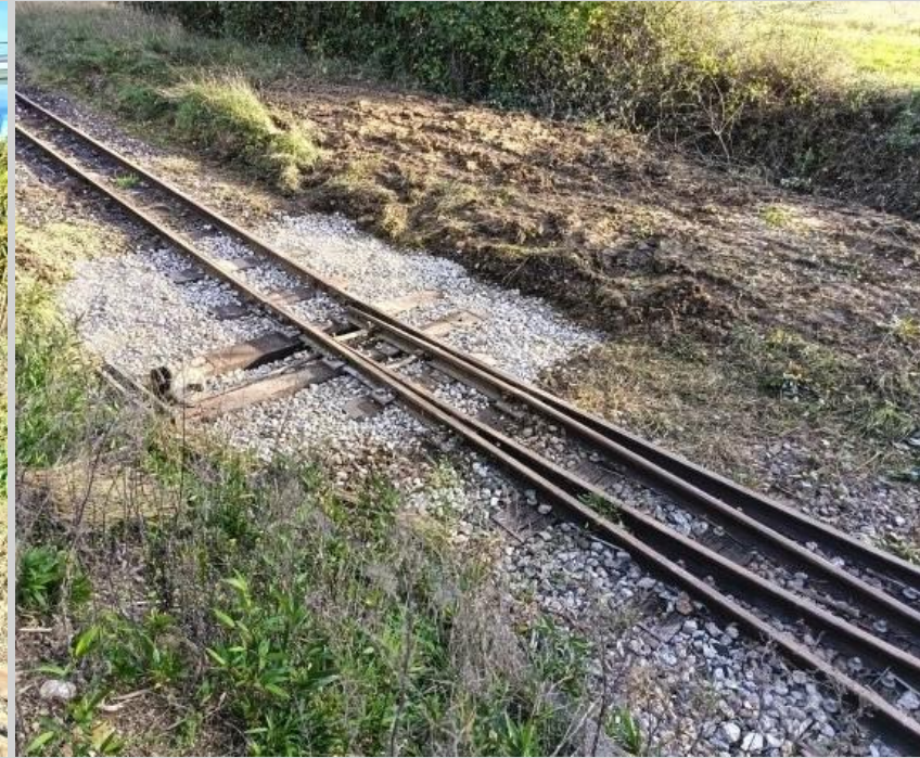
Une aiguille remise en forme
