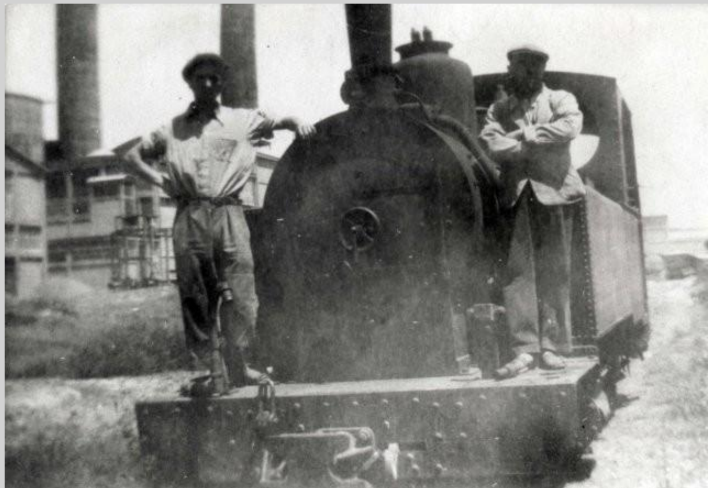
Première information vérifiée sur le devenir des locomotives des TVT après la fermeture. On ne sait pas si elle a été rachetée directement ou par l'intermédiaire d'un ferrailleur
