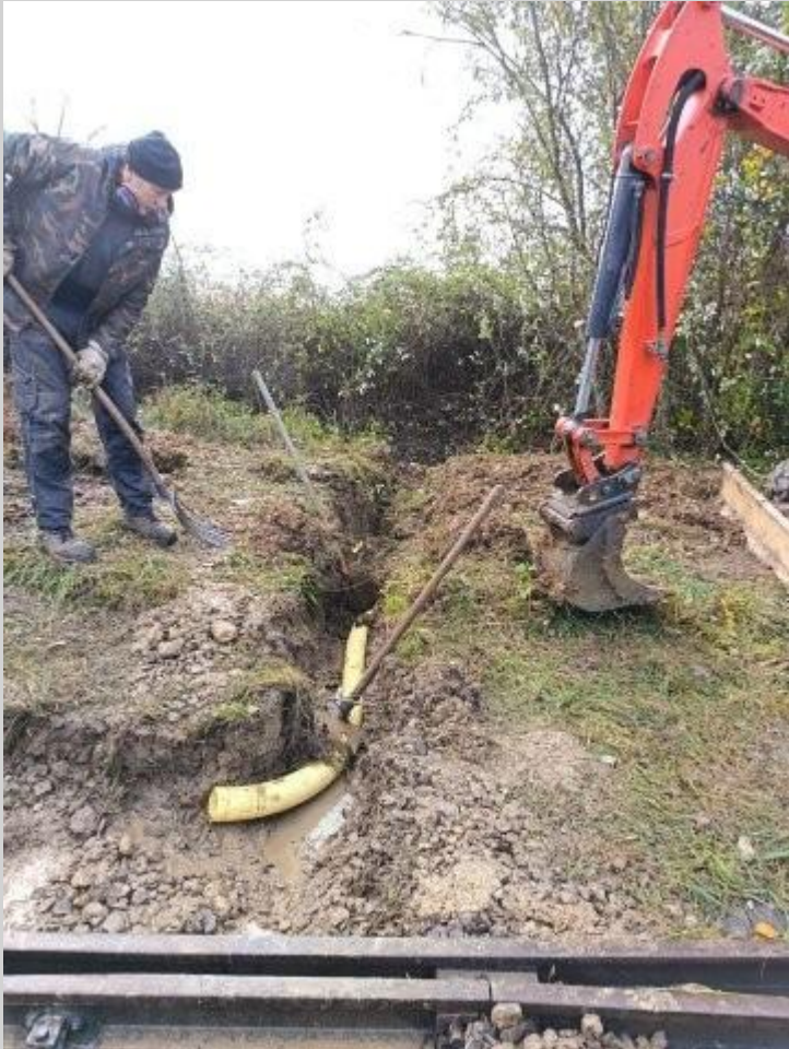
Pose du drain vers le fossé
