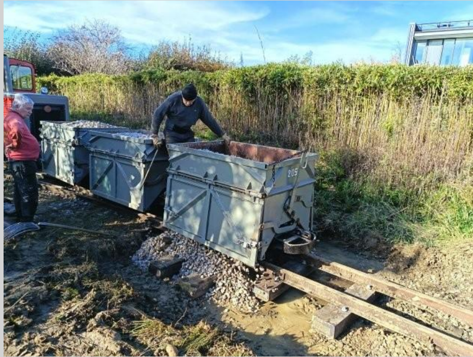
Remplissage en joli ballast tout neuf
