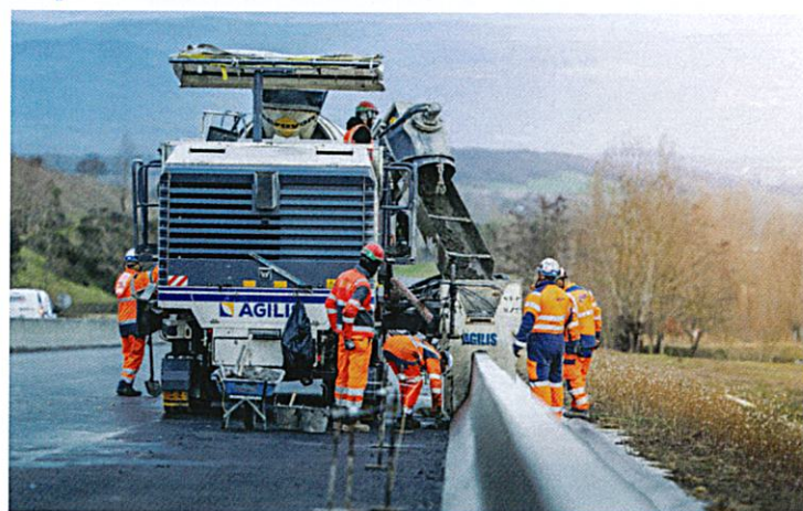
Atelier de mise en œuvre de glissières en béton armé (GBA)
