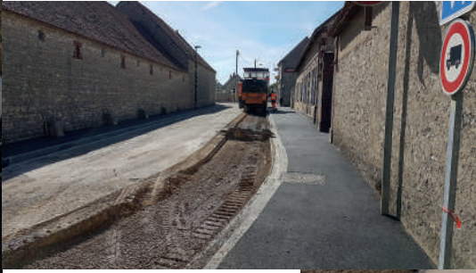
Enfouissement des réseaux (déploiement de la fibre)
