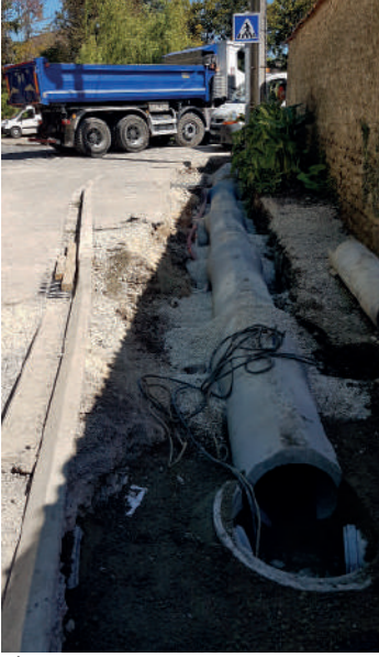
1 ère étape de l'enfouissement du réseau d'eau pluviale avant la réalisation du bassin de captage (rue de la herse)
