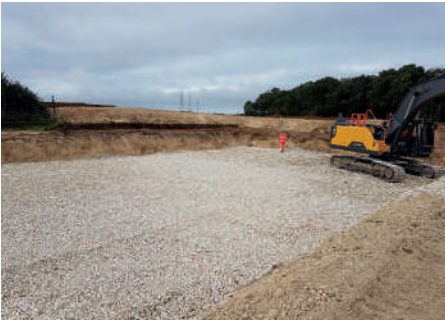
Agrandissement de la station d'épuration (Prise en charge par Chartres Métropole)
