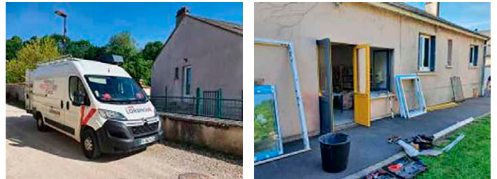
Changement des fenêtres de la bibliothèque
