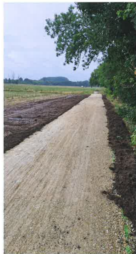
Réfection chemin de Halage
