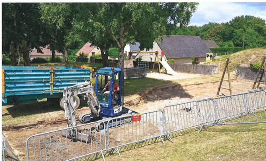
Travaux aire de jeux
