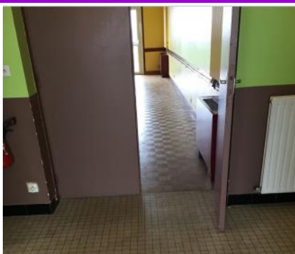
La salle des fêtes avant travaux
