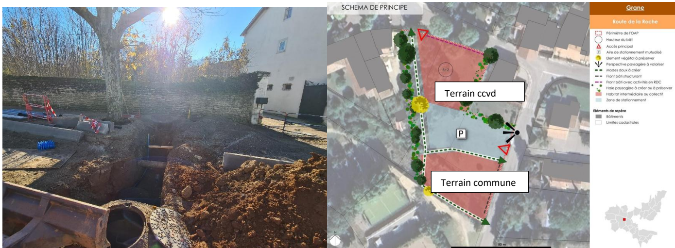
Création amorce réseau d'eau entrée terrain ccvd
