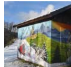
Le poste est le dernier maillon de la transformation de l'énergie.
