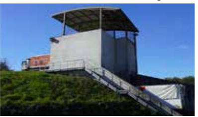
Le quai de transfert à Sillars permet aux véhicules de vider les déchets par le haut dans une remorque afin de les regrouper avant le transport vers la filière de traitement.
