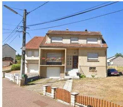
Maison suivant l'orientation parcellaire, Streetview, 2019
