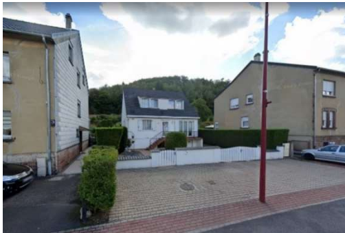
Maison construite au coup par coup, ne préservant pas l'alignement, Streetview, 2019
