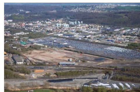
Friche de l'ancienne cokerie de Marienau et parc logistique (2009) – Source : univ-lorraine
