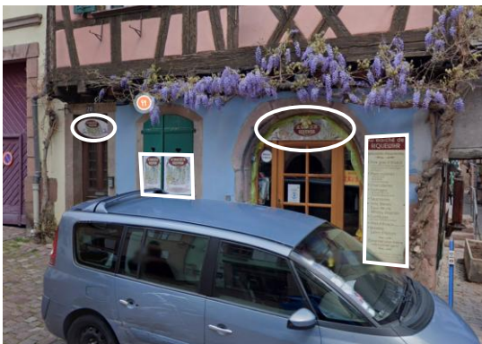
L'ACCUMULATION DE DISPOSITIFS D'ENSEIGNES EN FACADE
