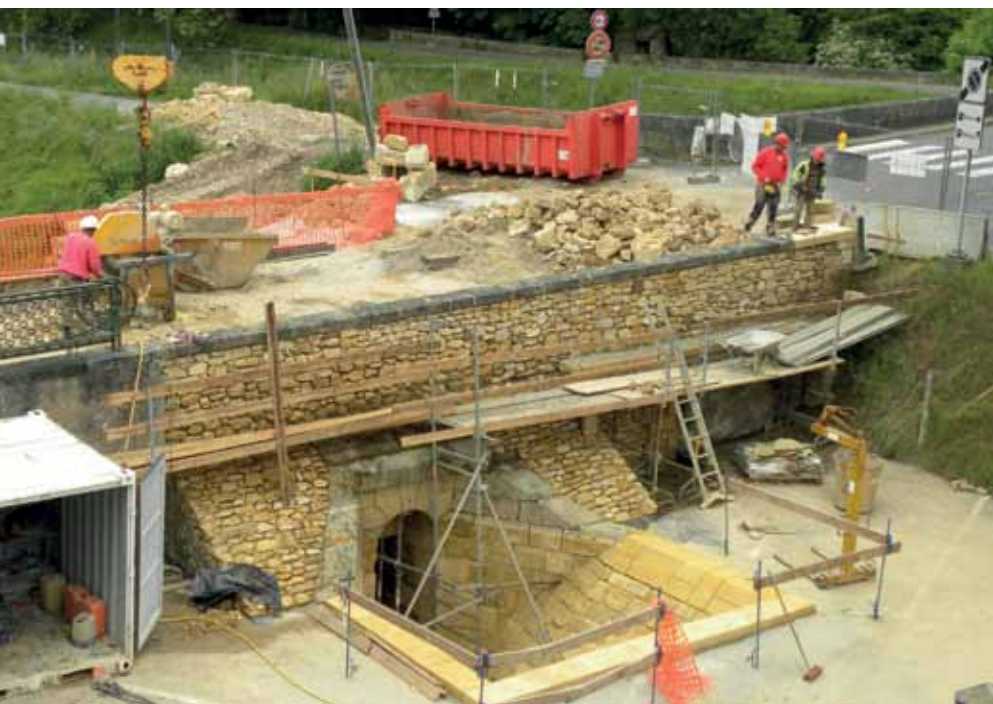
Le Canelet sera dorénavant visible et sécurisé, mais malheureusement le coût des travaux n'a pas permis la réfection de routes départementales en 2016
