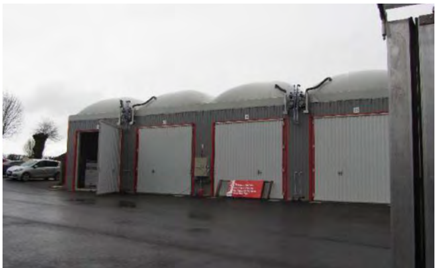
Les 4 digesteurs de l'unité de méthanisation du GAEC des Vallons, à l'intérieur desquels se développera la dégradation de la matière organique, produisant le biogaz. Les 3 digesteurs fermés sont déjà en fonctionnement.
