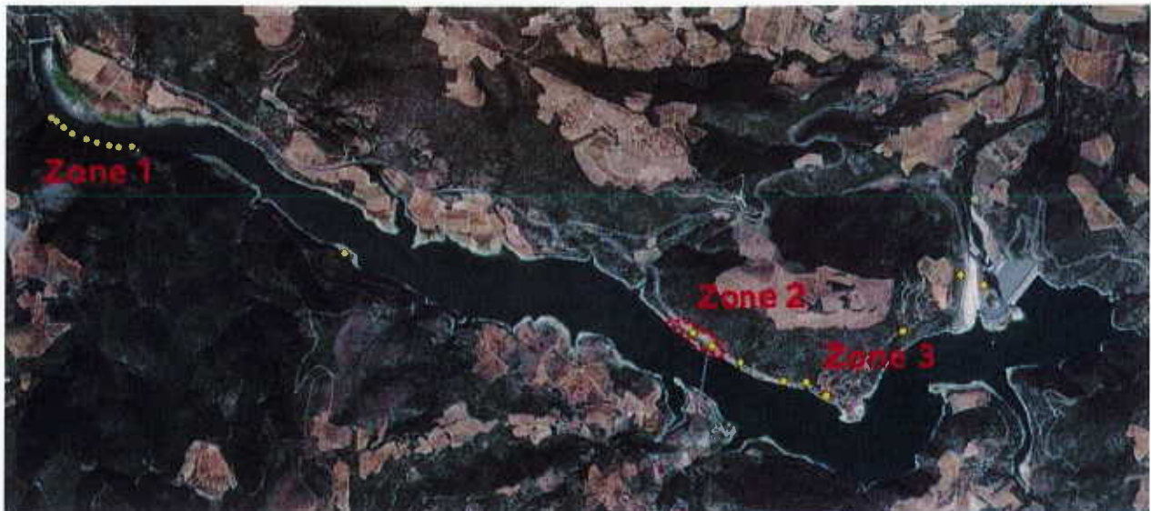
Zones présentant un risque de glissement de terrain potentiel source : EDD 2013
