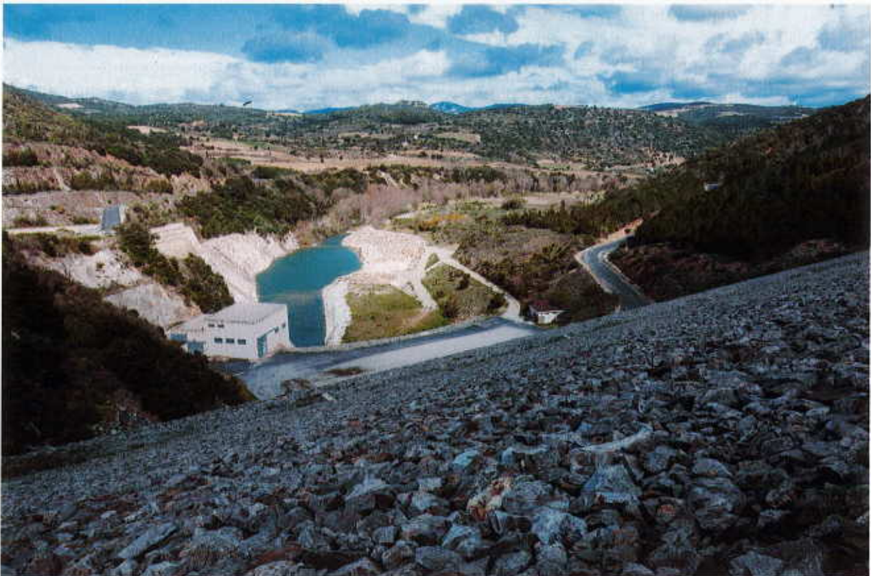
Parement aval du barrage de l'Agly vu depuis la crête
