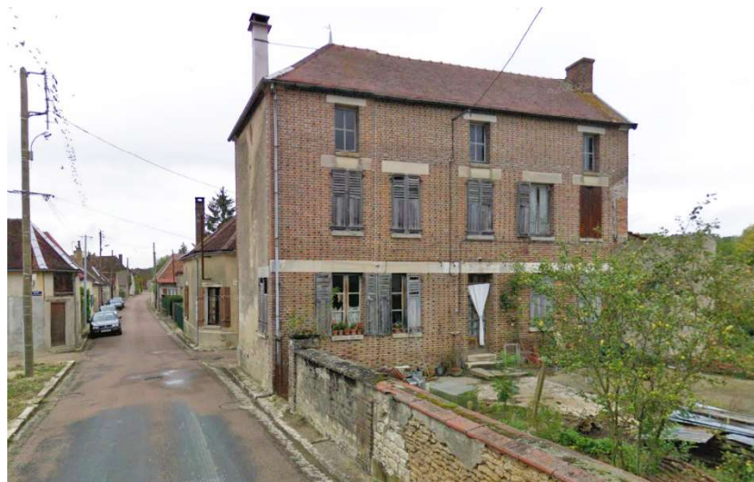
Secteur P2 Faubourgs : exemple de bâti « non repéré » - ou d'accompagnement.
