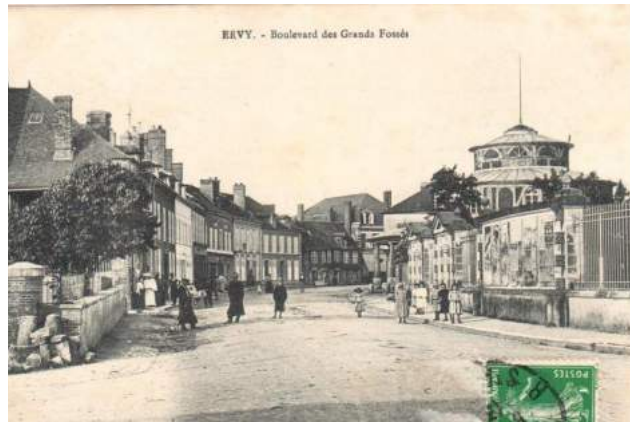
Boulevard des Grands Fossés devant l'ancienne école vers l'Est, avec la suppression de la clôture de l'école et le remplacement par des places de stationnement.
