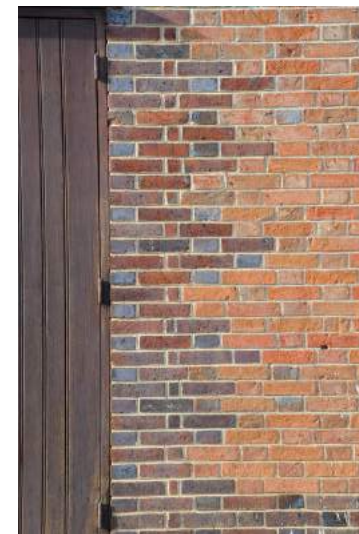
Soulignement de la baie par un jeu de couleur dans l'appareillage de brique.
