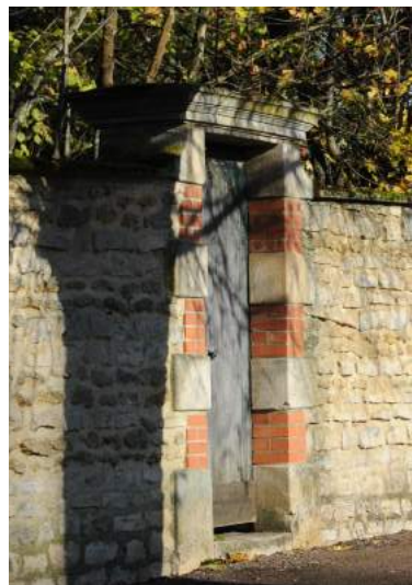
Mur de moellon calcaire, piles de porche mixte en pierre de taille et brique rouge, dessus de porte en pierre à corniche moulurée.
