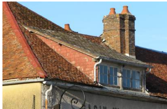
Lucarne chien couché, tuiles plates, cheminées en briques.
