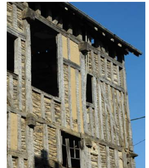
Lecture de la structure complète du pan de bois, présence de restes d'enduit sur les palçons entre les pièces de charpente..
