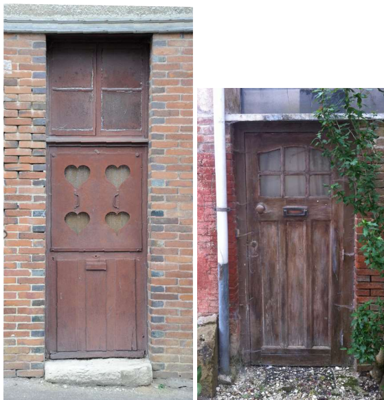
Portes d'annexes à conserver et entretenir.
