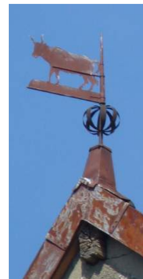
Épi de faîtage girouette orné d'un taureau.
