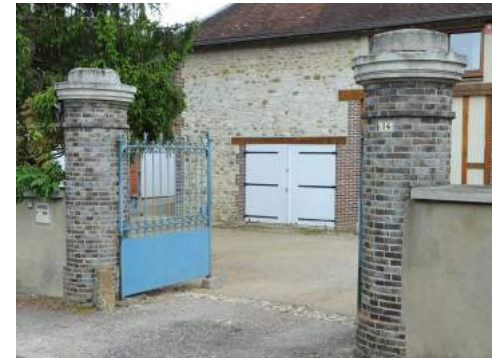
Piles cylindriques en briques bicolores avec couronnement mouluré en pierre.
