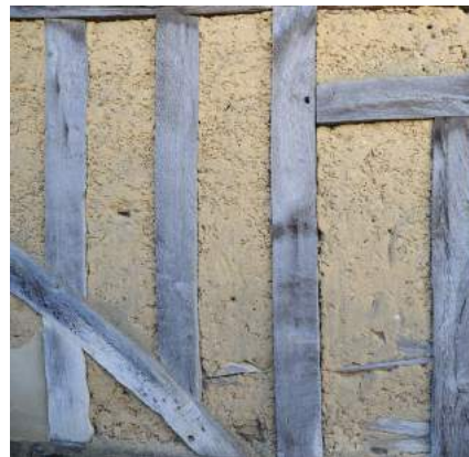
Pan de bois apparent avec hourdis en torchis; des restes d'enduit sont encore présents entre les bois.
