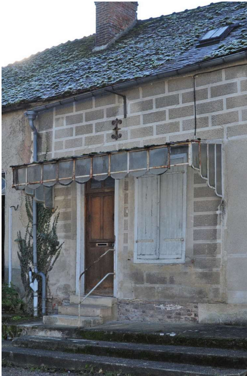
Marquise en acier protégeant un ensemble porte + fenêtre à conserver et entretenir.
