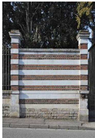
Maçonnerie mixte alternant brique bicolore et craie sur soubassement en moellons calcaire.
