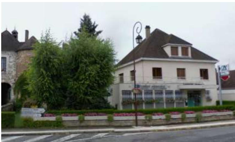
Après 1945, exemple : le bâtiment du Crédit Agricole, de type pavillonnaire. Les prescriptions de la section C relatives aux constructions neuves s'appliquent.
