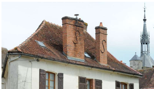
Conservation des cheminées.
