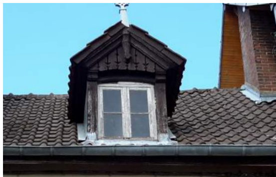
Lucarne jacobine à fronton de bois découpé et épis de faitage, couverture récente de tuiles à emboîtement type «petit moule».
