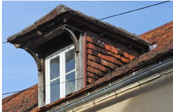
Lucarne capucine, jouées et toiture tuile plate.
