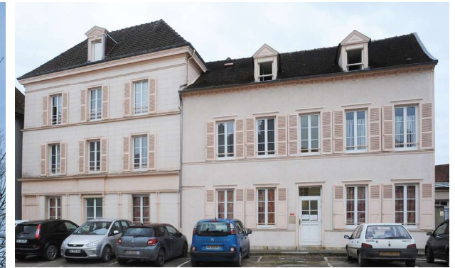
Pan de bois enduit avec modénatures de style Classique en bois (bandeaux, corniches, pilastres) et joints «façon pierre».
