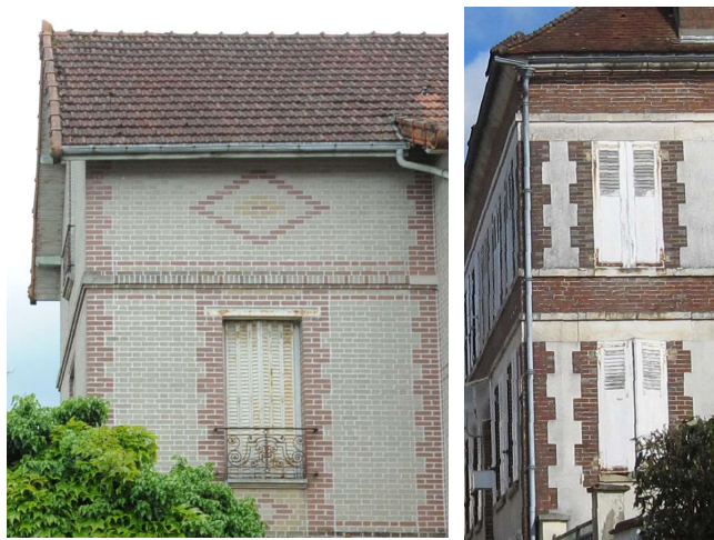
Persiennés métalliques pliantes en tableau, d'origine sur une maison en brique fin XIXème début XXème.
