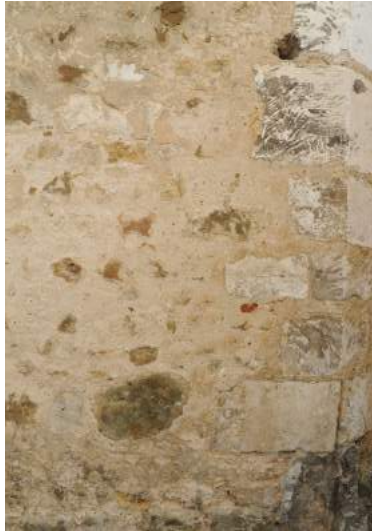
Moellon enduit à pierre vue, chaînage d'angle en pierre calcaire.
