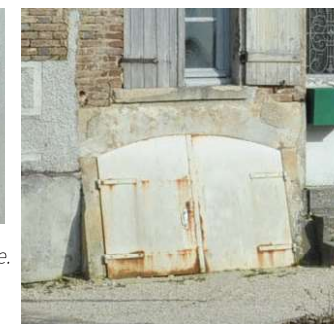
Trappe d'accès au sous-sol, en acier peint.
