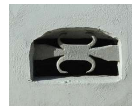
Soupirail de ventilation de cave.
