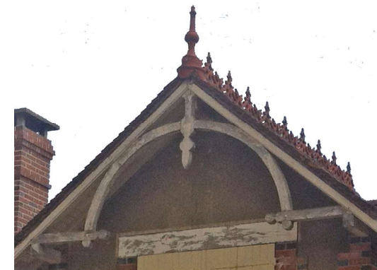
Grande lucarne avec ferme d'avant-corps en arc de cercle, ornements de couverture en terre cuite.
