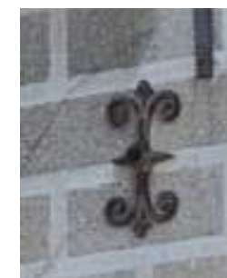
Clé de tirant ouvragée.
