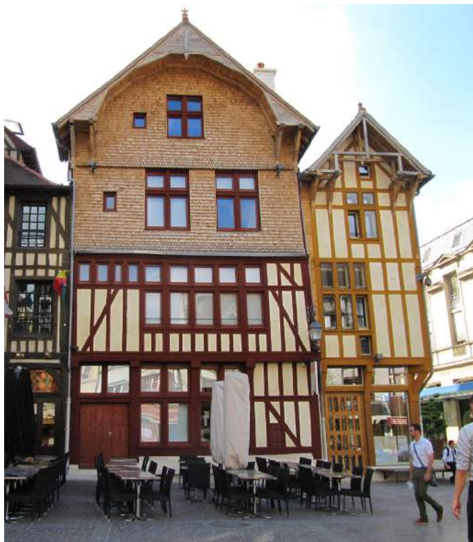
Deux étages de pan de bois recouverts par des tavaillons sur deux étages de pan de bois apparent.
