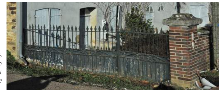
Portail trois vantaux en acier, pile et mur de clôture en brique.
