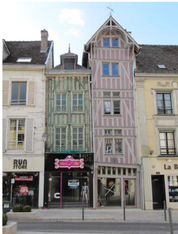
De gauche à droite : > immeuble en pan de bois caché sous enduit avant restauration > immeuble en cours de restauration > immeuble en pan de bois apparent restauré > façade en pan de bois, enduit plâtre et décor bois XVIIIème.
