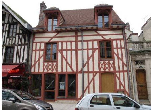
22 rue du Général de Gaulle AVANT (avril 2010) et APRÈS (janvier 2012)
