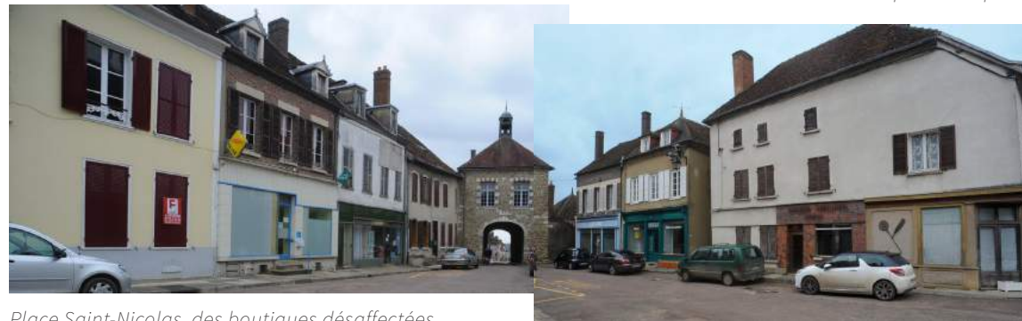
Place Saint-Nicolas, des boutiques désaffectées, d'autres utilisées par des services; la pharmacie dans un piètre état qui correspond mal à son activité.
