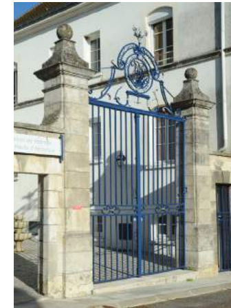
Ferronnerie dans une maçonnerie en pierre de taille.
