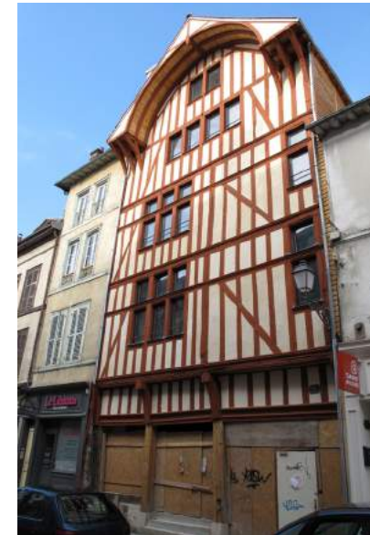
18 rue Georges Clémenceau AVANT (février 2009) et APRÈS (octobre 2011)
