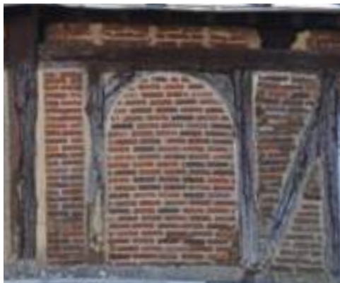
Pan de bois à hourdis de brique de la halle.
