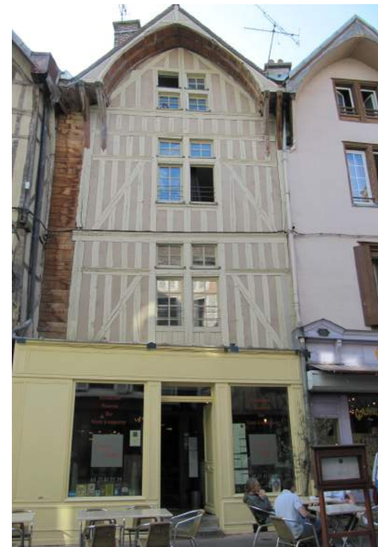
Deux immeubles «jumeaux» : l'un à pan de bois apparent restauré l'autre à pan de bois caché sous enduit.
