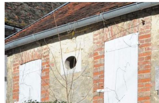
Maçonnerie de moellon calcaire enduit à pierre vue, avec cadres de baies en brique et détails en pierre de taille.
