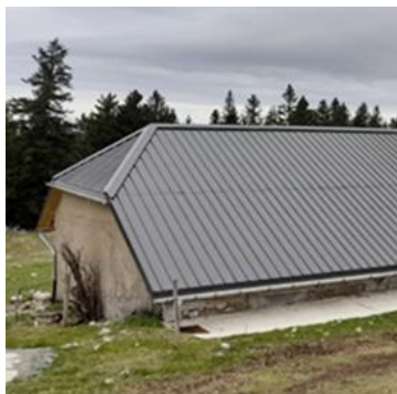
Toiture du chalet de la Grande Montagne.
