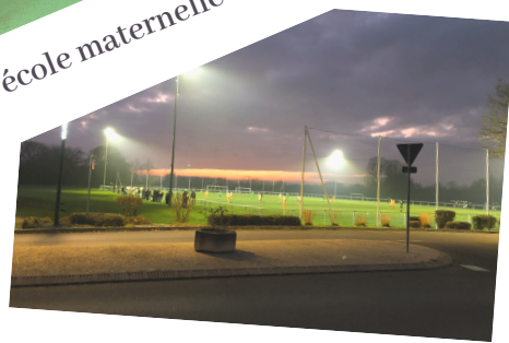
Eclairage du terrain de foot
