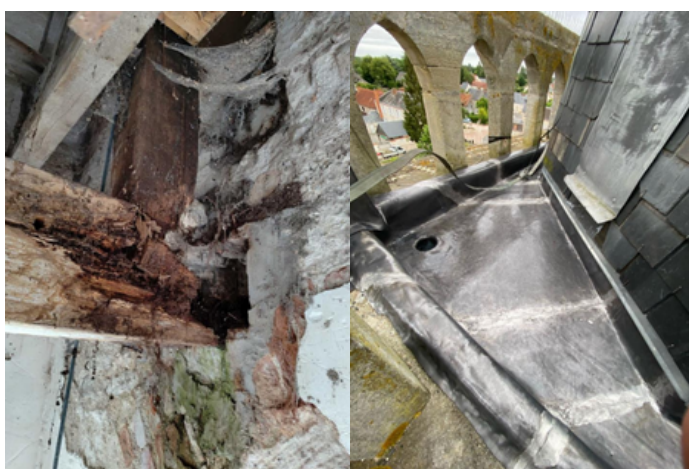
Porteuse dans mur et son poteau
