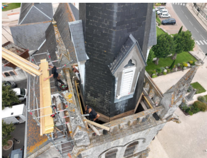
Reprise du support bois de la coursive
