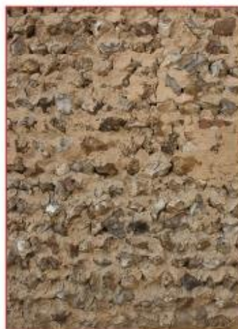
Maçonnerie de silex
