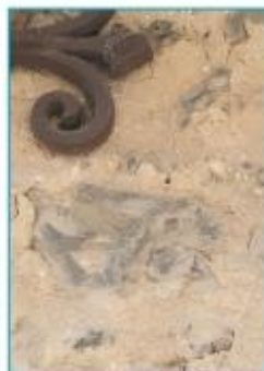
Enduit couvrant à base de chaux naturelle et de sablons.
