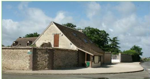
A gauche, en 2007, la façade sur rue de l'ancienne grange transformée en gîte. A droite, en 1936, la façade sur cour de la même grange.
