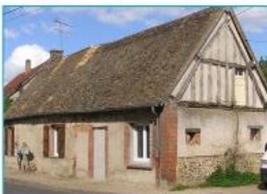
Colombage et remplissage torchis, maçonnerie enduite, silex et brique. Abondant
