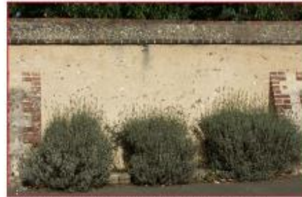
Mur de clôture en bauge avec chaperon maçonné et contreforts en brique. Escarpain
