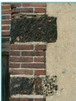
Maçonnerie en pierre de grison et brique.
