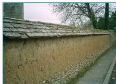
Mur en terre crue, soubassement silex. Broué.
