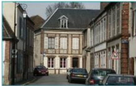
Maisons en maçonnerie de moellons enduite et brique appareillée. Brezolle.
