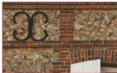
Maçonnerie de brique et silex.
