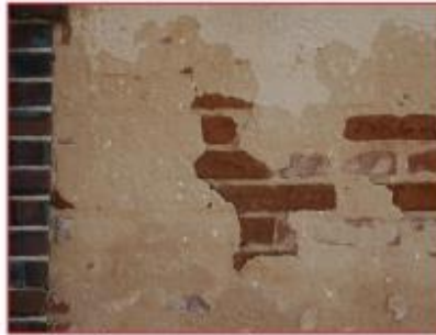
Ancien enduit ocre rouge et brique.
