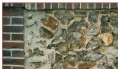
Maçonnerie de brique et silex.
