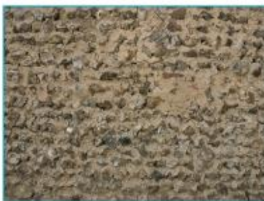
Le soubassement des murs en bauge : rognons de silex et mortier de terre crue. Laons.
