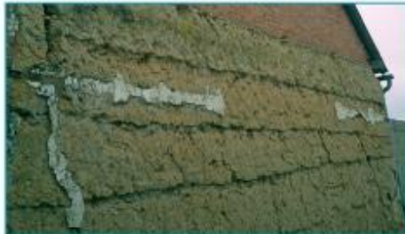
Mur en bauge. Broué.
