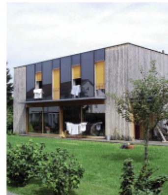
Les capteurs posés verticalement participent pleinement de la composition de la façade. Maison individuelle à Wolfurt (Vorarlberg, Autriche) © CAUE 78
