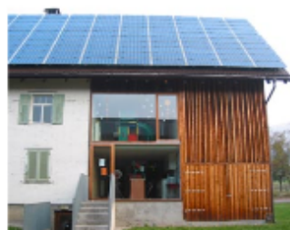
Un ensemble de capteurs recouvre toute la surface du toit, comme une nouvelle couverture. Crèche à Zwischenwasser (Vorarlberg, Autriche) © CAUE 78
