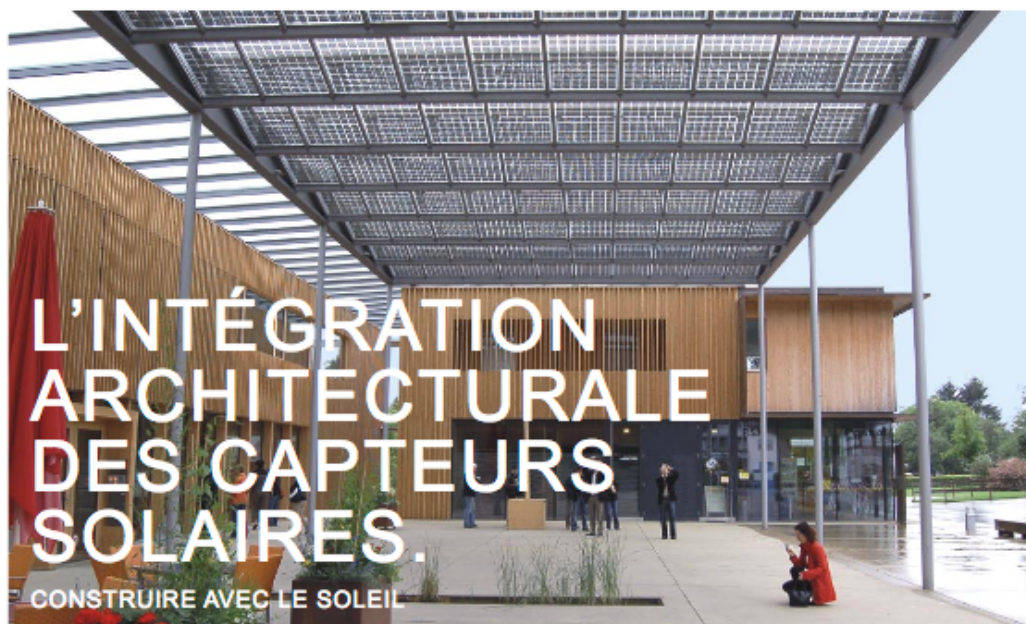
Un vélum de capteurs photovoltaïques abrite une place publique. Ludesch (Vorarlberg, Autriche) © CAUE 78
