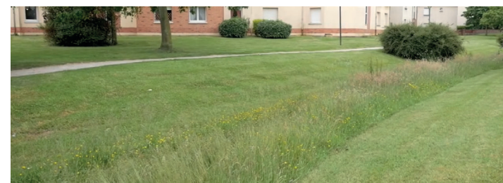
La noue, un incontournable de la gestion extensive et intégrée des eaux pluviales. Elle s'adapte à toutes les ambiances, tantôt urbaine, tantôt rurale.
