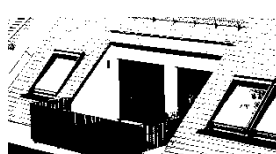
Tropézienne, crevée de toiture
