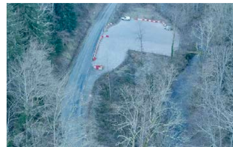
Réaménagement du parking de Fontestorbes
