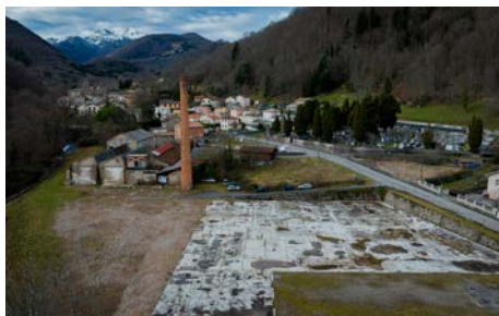
Démolition de la SAB à Montferrier afin d'accueillir la Maison du Grand Site de France
