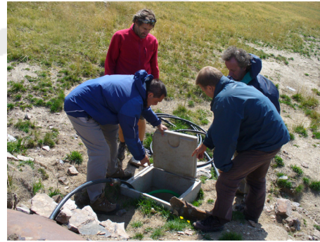
Travaux au chalet d'alpage
